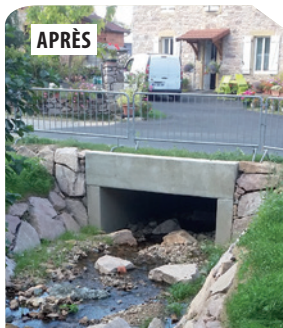
Pont en U à La Roche (Belmont-de-La-Loire)
