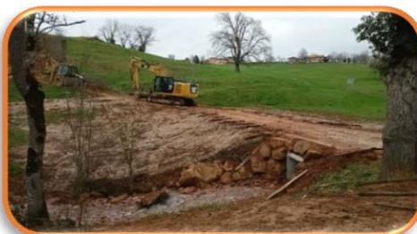
*Remplacement de buses infranchissables par des ponts cadre*
